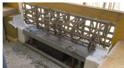
Eingebaute, spezielle Zug-Druckanker vor dem Betonieren
