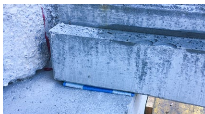
Lager vor dem Betonieren von oben
