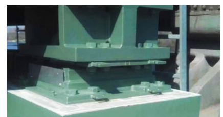
Ein RESTON®SPHERICAL Kalottenlager nach Abschluss der Installation
