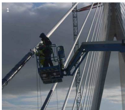
1 Installation des capteurs sur un pont haubané
