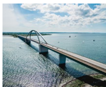
Pont Irtysh River (KZ)
