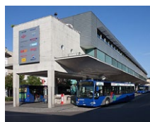
Gare d'Uster, CH
