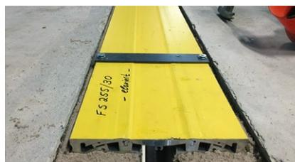
Pose et raccordement d'une section du joint
