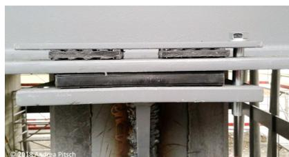
Paliers élastomères pour une installation sur un corbeau en béton
