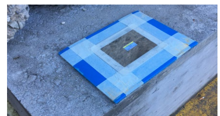
Appui avant le bétonnage vu de dessous
