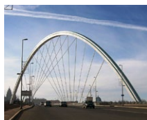
Ramstore Bridge (KZ)
