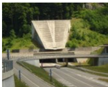
Tunnel Mont Terri St., (FR)
