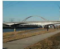
Dintelhaven Bridge (NL)
