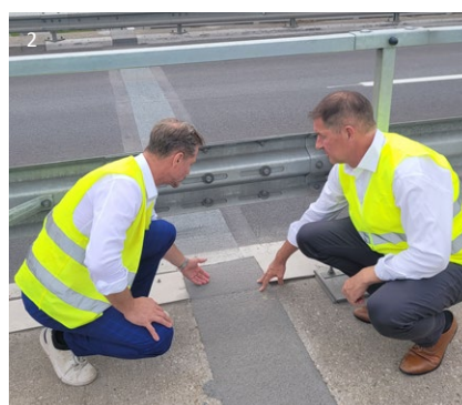
滑动式梳齿伸缩缝
