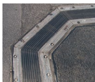
橡胶板式伸缩缝
