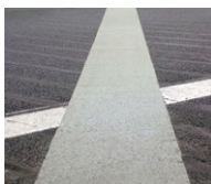
无缝伸缩缝
