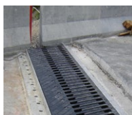
滑动式梳齿伸缩缝
