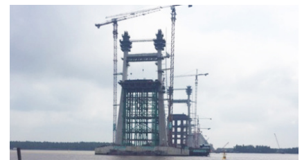
在建的巴赫丹大桥
