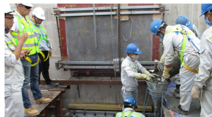
安装中的玛格巴LASTO-HDRB高阻尼橡胶支座
