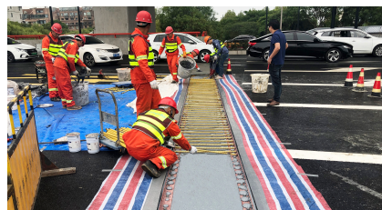
在龙东大道上施工的博力封®无缝伸缩缝
