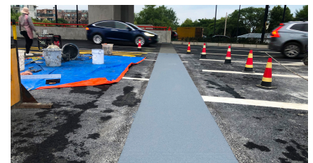
施工完成的博力封®无缝伸缩缝
