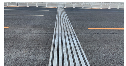
安装在新首钢大桥上的TENZA®MODULAR模数式伸缩缝LR7
