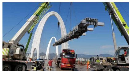
吊装过程中的TENZA®MODULAR模数式伸缩缝LR7
