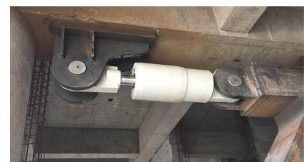
安装后的RESTON®SA阻尼器
