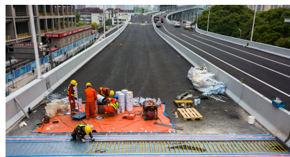
在天目路上施工的博力封®无缝伸缩缝
