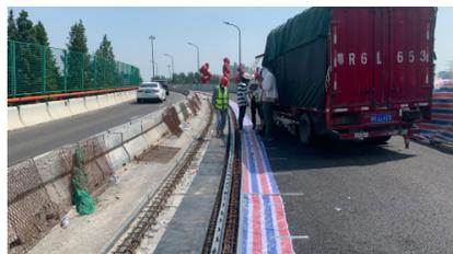
完成安装的博力封®聚氨酯填充式伸缩装置
