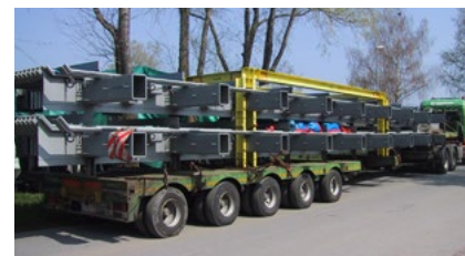
将玛格巴模数式伸缩缝运输至现场
