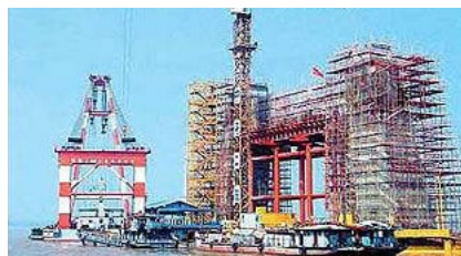
该综合项目起始阶段建造桥塔
