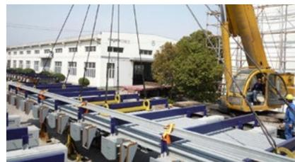
2000年安装在南京长江第二大桥上的TENZA-MODULAR LR12模数式伸缩缝
