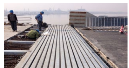
施工现场：浇筑混凝土前的准备
