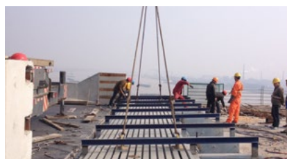
伸缩缝安装在合适的位置
