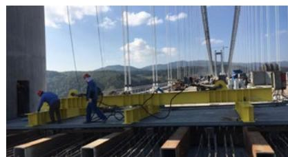
现场安装配有抗震系统的伸缩缝
