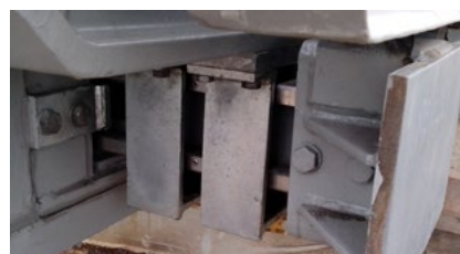
TENZA-MODULAR LR3模数式伸缩缝位移系统的详细视图
