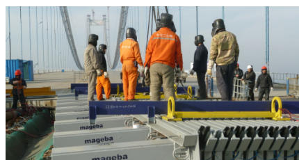
待安装的模数式伸缩缝
