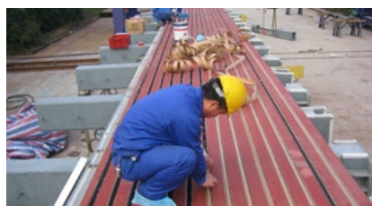
将ROBO-GRIP防滑面安装在伸缩缝上
