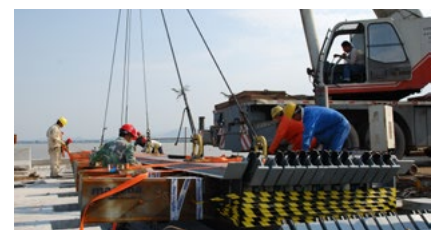
TENSA-MODULAR模数式伸缩缝LR14安装在之江大桥上
