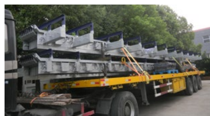
TENSA-MODULAR模数式伸缩缝运往施工现场
