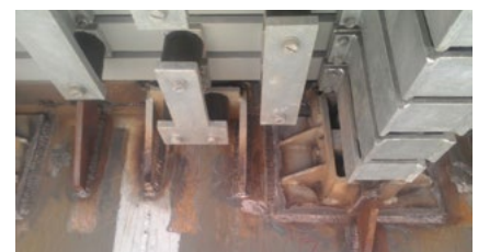
位移箱端头焊接在钢箱梁上
