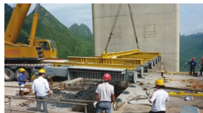
一条安装中的TENZA-MODULAR模数式伸缩缝
