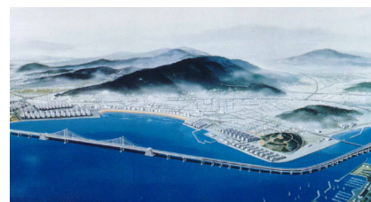
Das 7.5 km lange Gwangan Brückensystem
