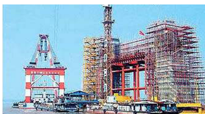
Bau des Brückenpfeilers
