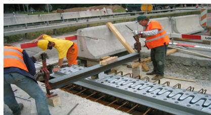
Ruhiges Überfahren dank neuartiger Stützrippen-konstruktion System ROBO®DUR
