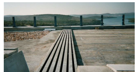
Die installierte mageba Dehnfuge Typ LR6
