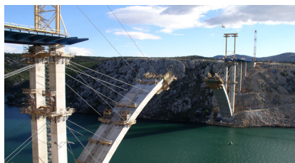
Die Brücke während des Baus
