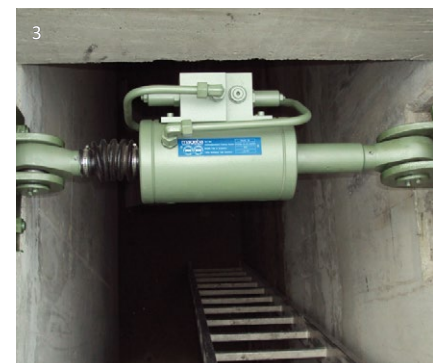
1 Leistungsdiagramm 2 Abdichtungssystem 3 Installierter RESTON®STU
