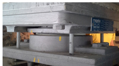
Je Widerlager übernehmen 5 RESTON-POT Topflager TA1/TE1 die Lasten aus dem Überbau
