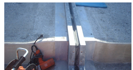
Fahrbahnübergang RB50 bei den Gerbergelenken im Gehwegbereich
