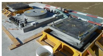
Eine Schock-Übertragungs-Einheit wird in die Fahrbahn des Viadukts eingebaut
