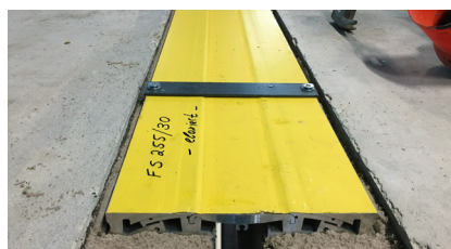
Im Mörtelbett verlegte MIGUTRANS Schwerlastfuge
