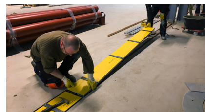
Verlegen und Andocken eines Fugenabschnitts
