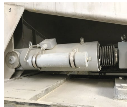
1 LASTO®BLOCK Verformungslager 2 RESTON®SPHERICAL, Kalotte auf Lagerunterteil 3 RESTON®SA Stoßdämpfer
