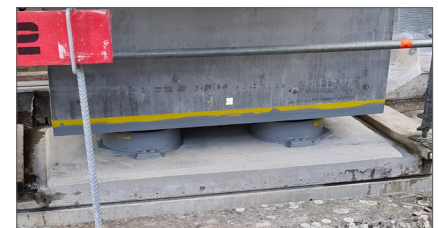
Zwei Topflager unterhalb einer Stütze nach dem Untergiessen mit Beton
