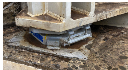
Ein RESTON®POT Topflager TE vor dem Untergiessen
