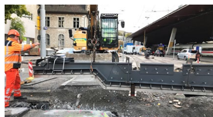
Ein Abschnitt der Dehnfuge wird eingehoben
