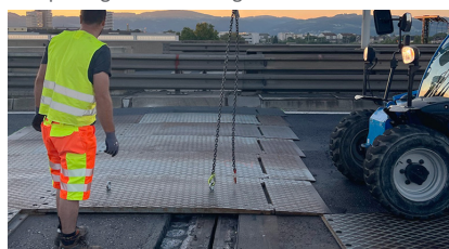
Platzieren des mageba Mini-Flyover über der Aussparung der neuen Fuge
