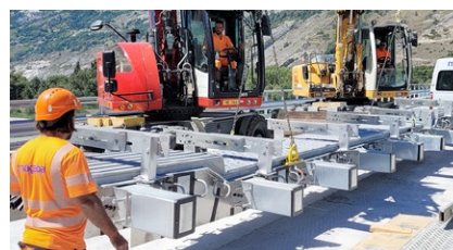
Anheben einer TENSA®MODULAR LR-LS Fuge
