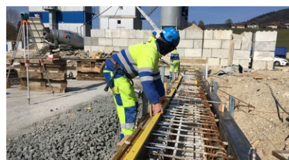
Eingebaute Fuge mit Distanzhalter und Schutzfolie (wird beides entfernt)
