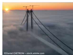
Most Braila, Rumunsko
