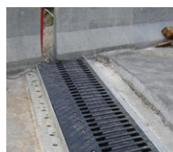
Podporovaný hřebenový mostní závěr
