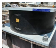
Elastomerová ložiska s olověným jádrem
