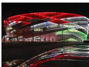
MVM Dome, Maďarsko
