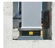
Vyztužené elastomerové ložisko
