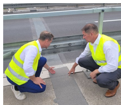
Podporovaný hřebenový mostní závěr
