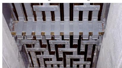
Lamellenfuge funktioniert tadellos auch bei starkem Längsgefälle (hier 6%)
