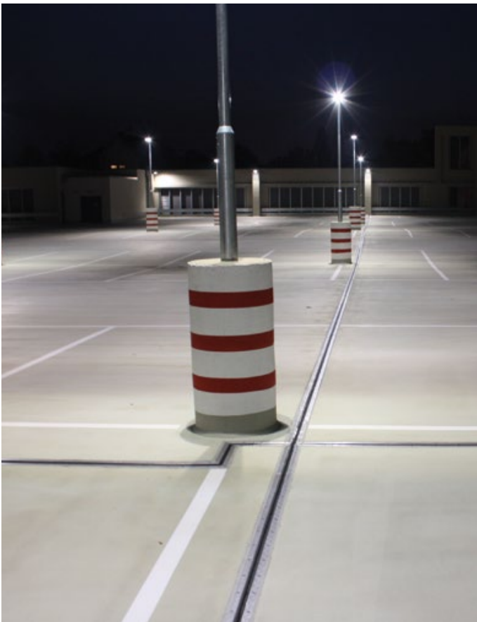
Parkdeck Einkaufszentrum Dresden, Löbtau
