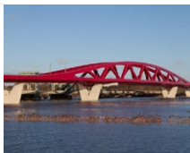
Ijssel Brücke (NL)
