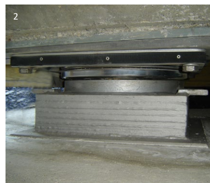
1 Einbaufertiges KE Lager mit Staubschutz und Bewegungsanzeige 2 Eingebautes KA Lager mit abgenommenen Staubschutz
