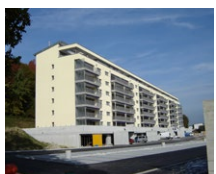
Bâtiment locatif, Givisiez
