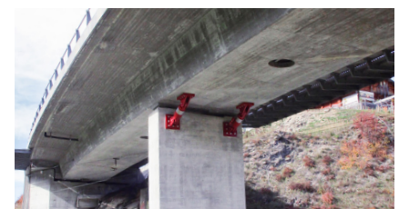
Fertig installierte STU 1700 Stossdämpfer
