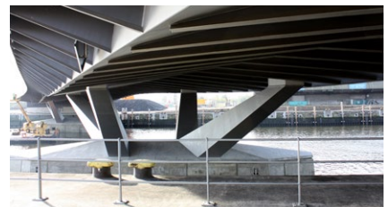
V-Träger mit Verformungs- und Kalottenlagern
